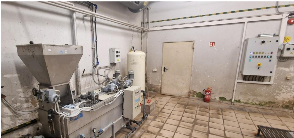
4 pav. Demontuojama flokulianto ruošimo įranga
