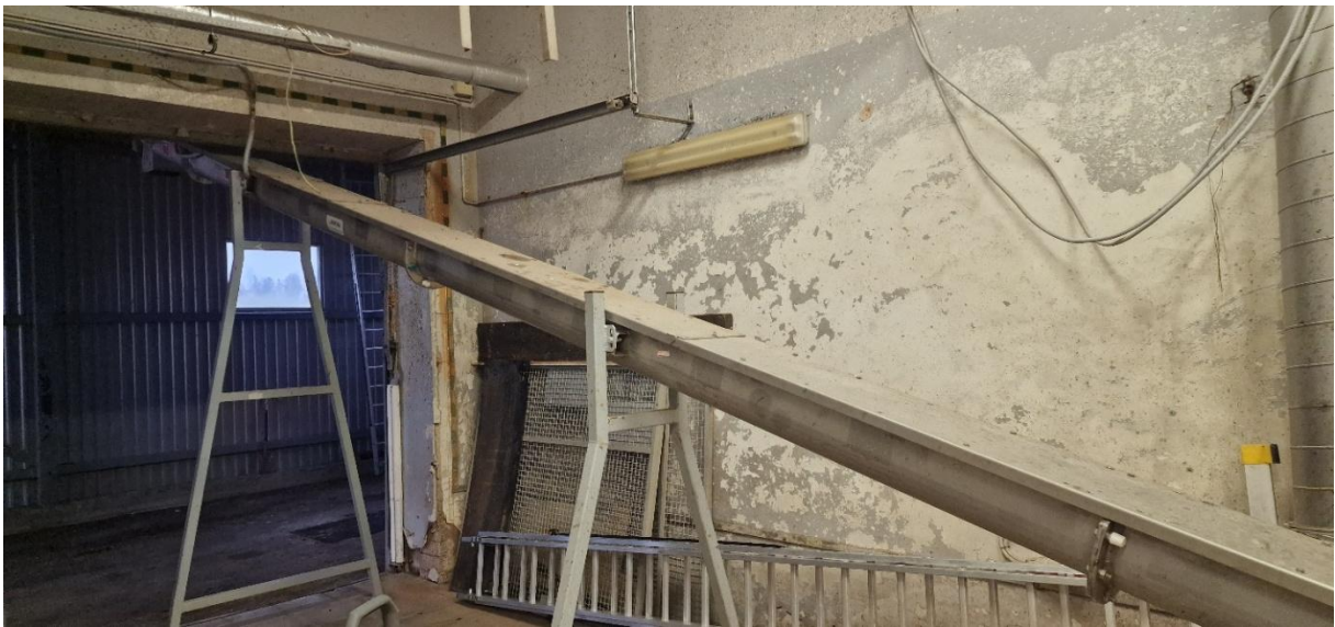
5 pav. Demontuojamas nusausinto dumblo transporteris
