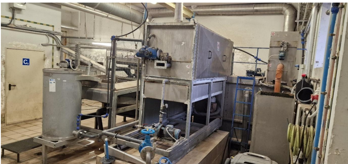
3 pav. Demontuojamas dumblo tankintuvas
